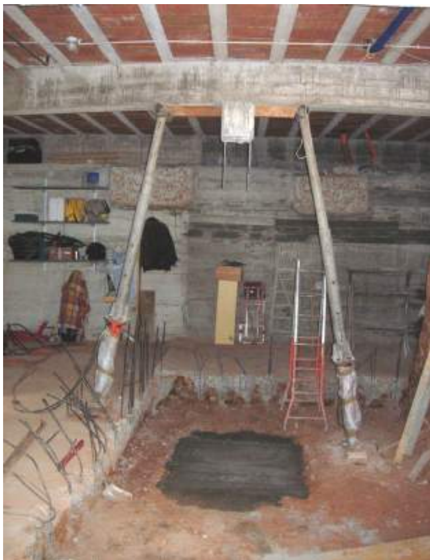
Foto 2 – Puntellamento sostitutivo del trave con martinetti idraulici.
