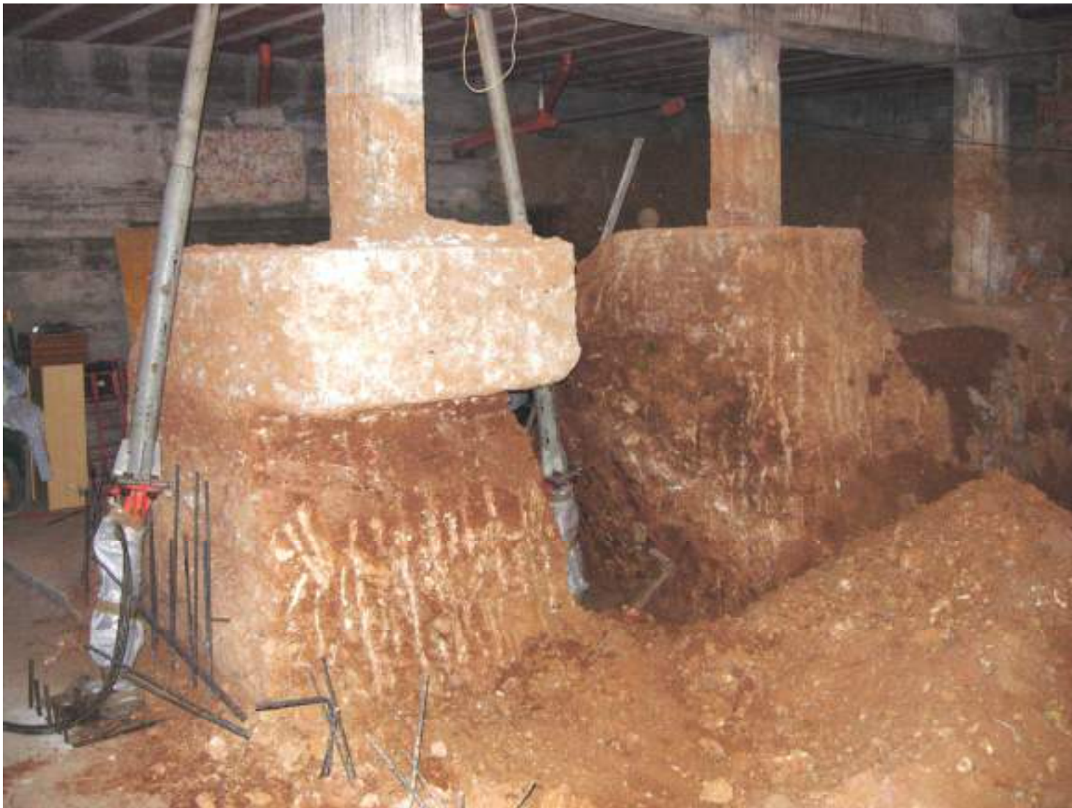
Foto 1 – I tre pilastri oggetto di questa relazione: il 1° e il 3° pilastro saranno prolungati, mentre il 2° verrà eliminato dopo aver rinforzato il trave del solaio.
