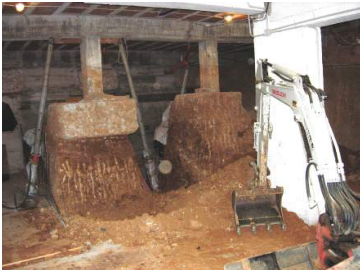
Foto 2 – Puntellamento sostitutivo del trave con martinetti idraulici.
