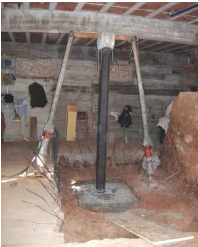
Foto 4 Inserimento di martinetto meccanico “a perdere”. Il martinetto meccanico è munito di un dispositivo atto a recuperare i cedimenti della nuova fondazione prima di collegare questa al soprastante trave, neutralizzando così anche i più piccoli movimenti di assestamento del corpo fabbricato.
